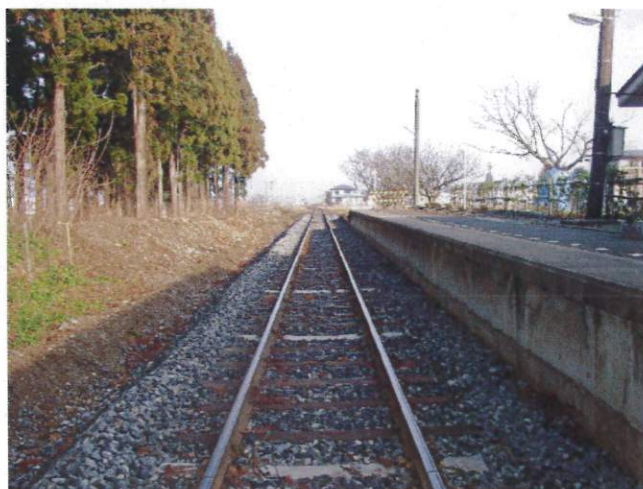
軌道道床交換（羽前成田駅構内）
